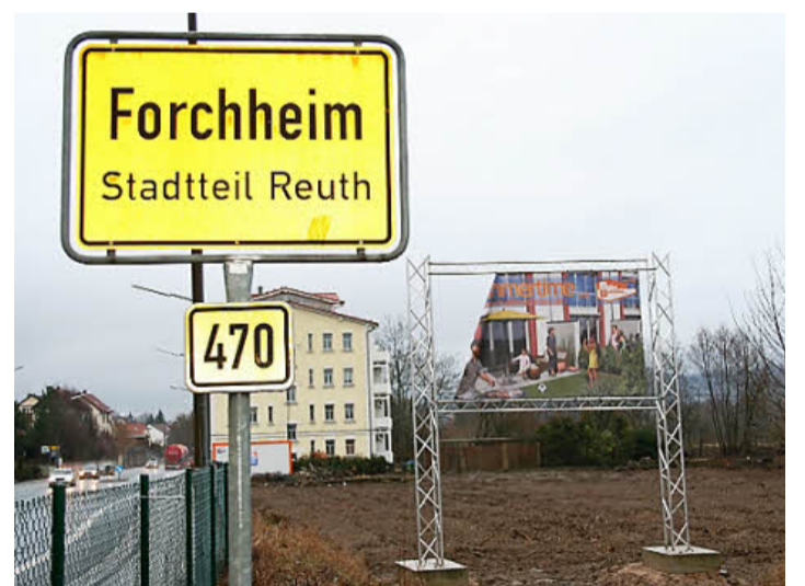
An der Bayreuther Straße entsteht die Wohnsiedlung Reuther Auen.
